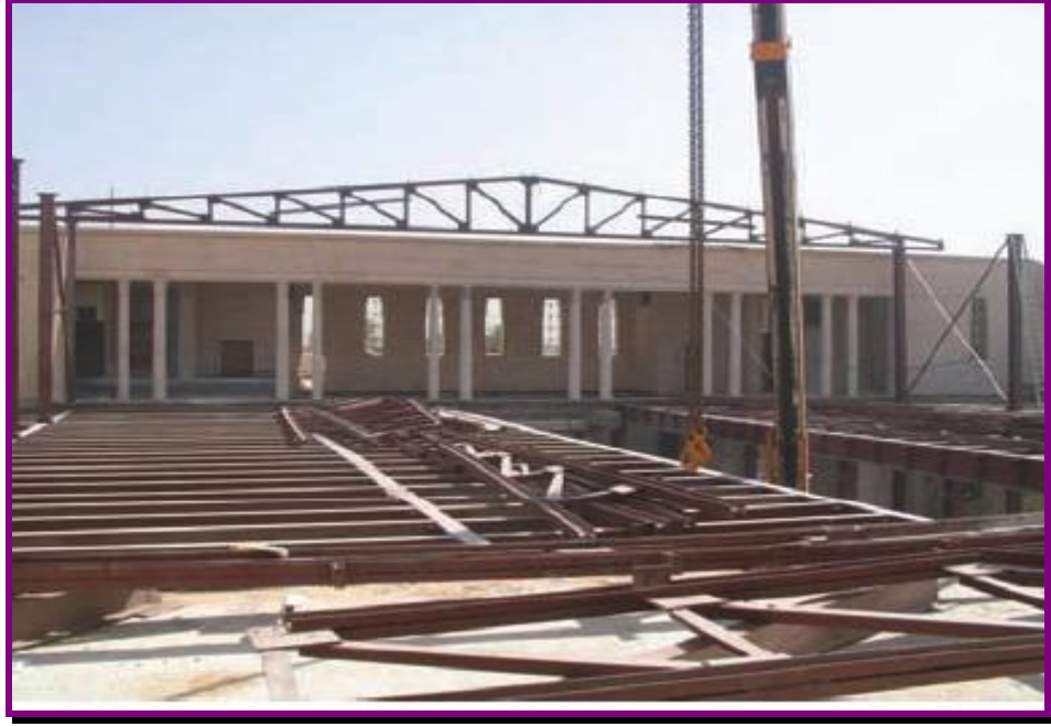
بناء الطابق الثالث (الصورة من المتعهد)
