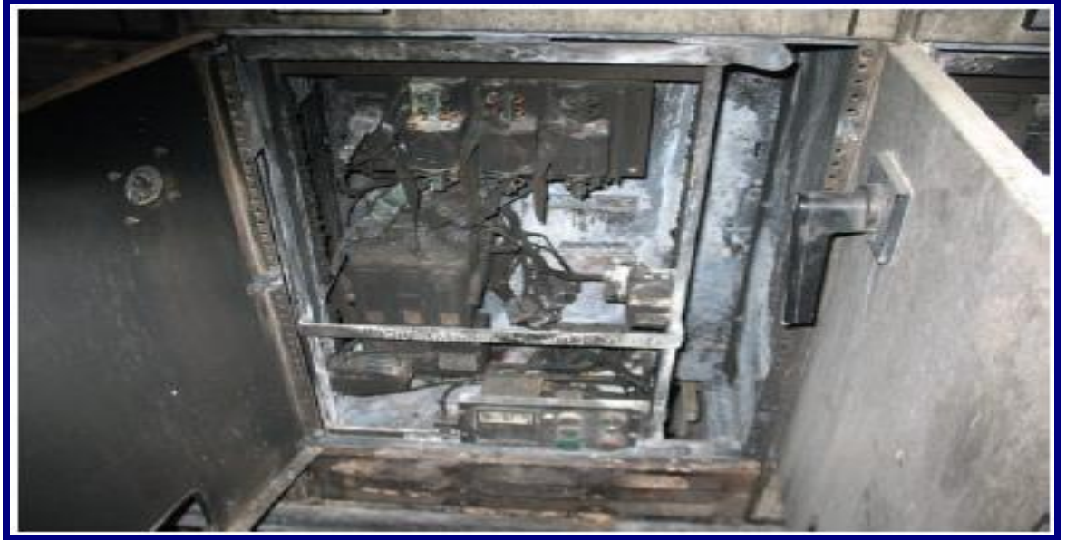
أسلاك محترقة في مركز السيطرة في محطة الدورة. نتج الحريق عن قفز ومض المستثير الناتج عن "الاحتباس الشديد"
