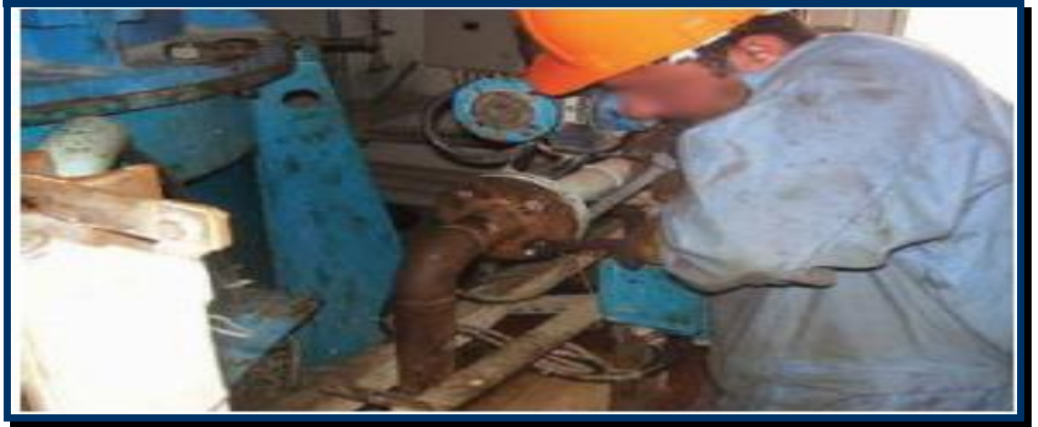
إعادة تأهيل المضخات (الصورة مقدمة من USACE)
