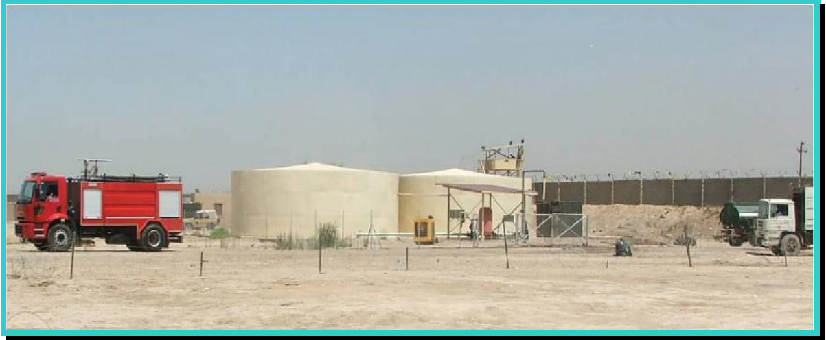
خزانات المياه في قاعدة لواء الرشيد
