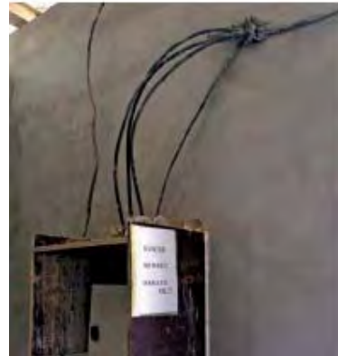
توصيلات كهربائية غير صحيحة في نقطة الدخول في الربيعة
