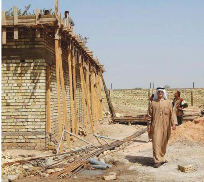
شيخ يعاين وحدة إدماج مياه وشبكة لتوزيع المياه تابعة لسلح الهندسة في الجيش الأميركي، في بابل
