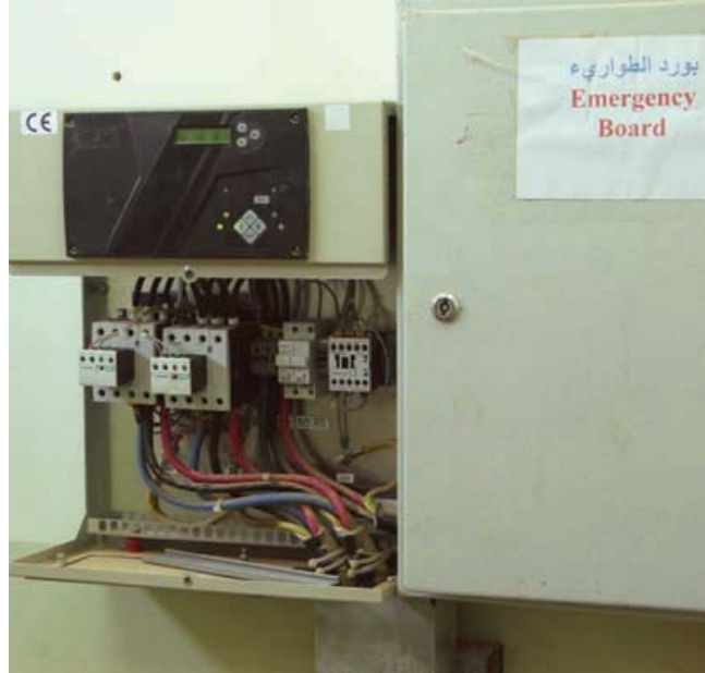
غطاء الوصول منزوع من مفتاح التحويل الكهربائي للمولد المتوقف عن العمل
