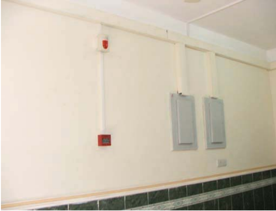
تركيبات علب جديدة للأسلاك، ومآخذ الغيار الكهربائي، ولوحات التوزيع الرئيسية الجديدة
