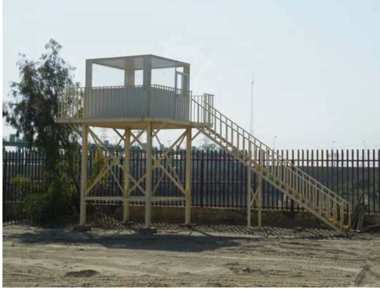
مبنى الحرس والسياج
