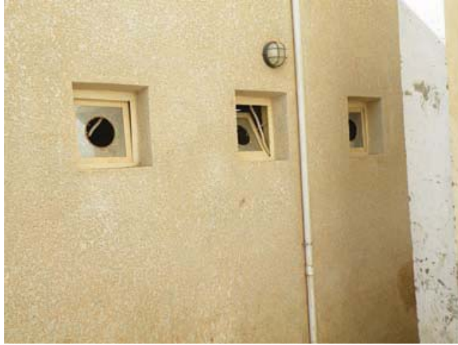
مراوح طرد الهواء منزوعة من مباني المراحيض
