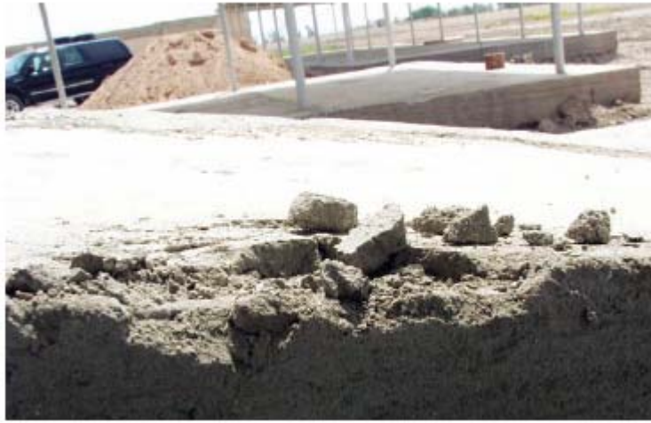
صورة الموقع رقم ١٣: خرسانة مهشمة على سطح الممر المنحدر للمركبات
