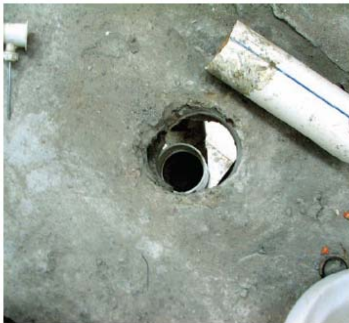
صورة الموقع رقم ٢٣ : أجزاء من أنابيب المياه خلال عملية إزالتها
