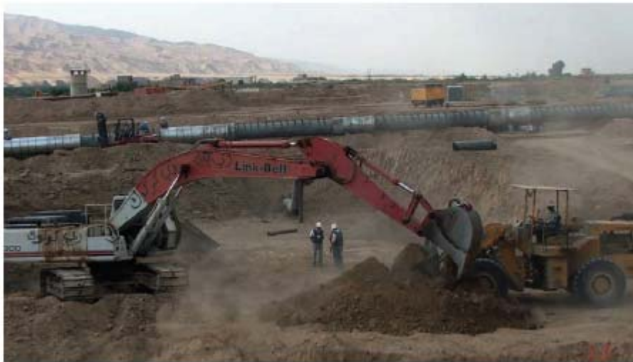
إنشاء خط أنابيب في شمال شرق العراق
