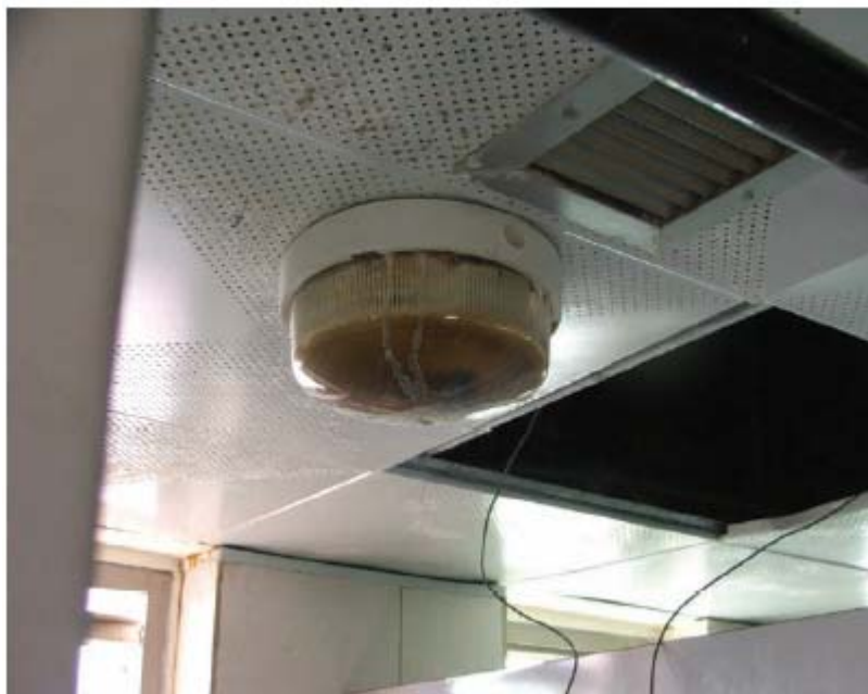
صورة الموقع رقم ٢٢ : مصابيح سقفية مملوءة بالبول وأسلاك كهربائية متدلّية
