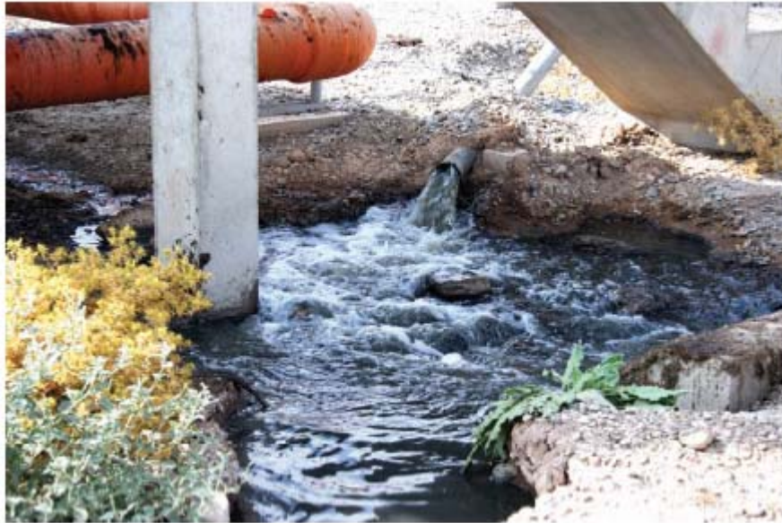
صورة الموقع رقم ١١: مياه الصرف الصحي غير المعالجة تضح بعيداً عن الموقع عبر حفرة سطحية
