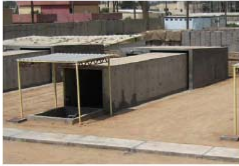
صورة لموقع رقم ١٦ : محطة إطلاق نار المسدس تظهر حفرة الإطلاق، وأنبوب إطلاق النار، وحظيرة الهدف
