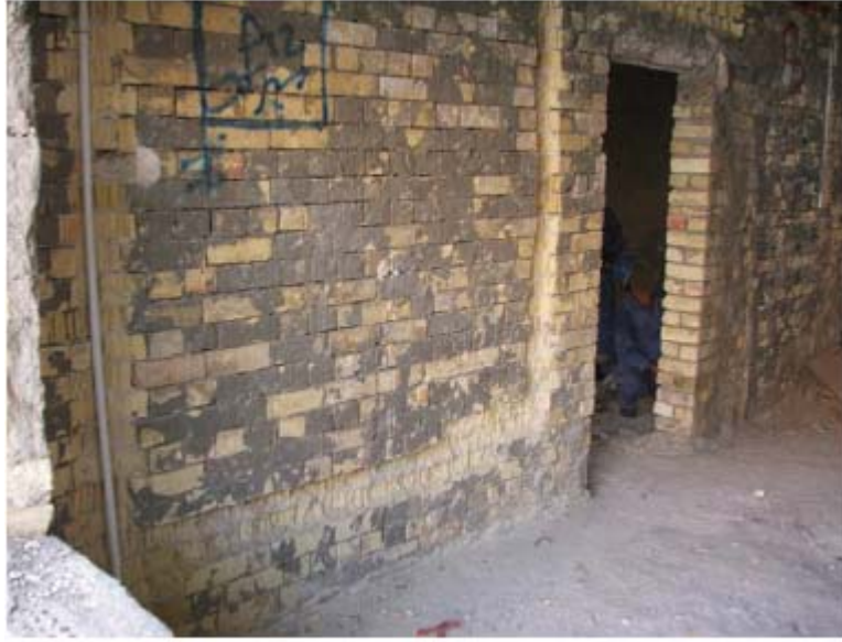
صورة الموقع رقم ٦: الجدران المكشوفة في المبنى B1 قبل إعادة تجسيصها (توريقها)
