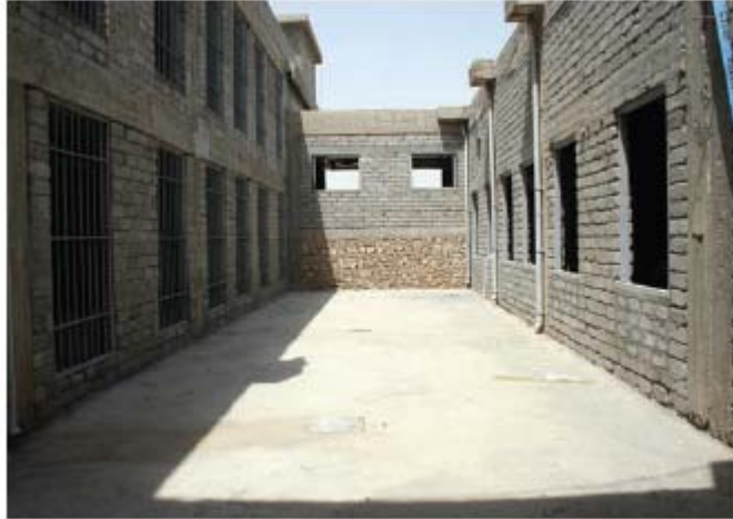
صورة الموقع رقم ٨: تركيب تجميعات، قضبان للحماية الأمنية في الطابق الأرضي
