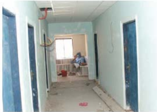
صورة الموقع رقم ٥: إنشاءات في المبنى B1، (أجنحة المرضى، المختبرات، وغرف التصوير بالأشعة)
