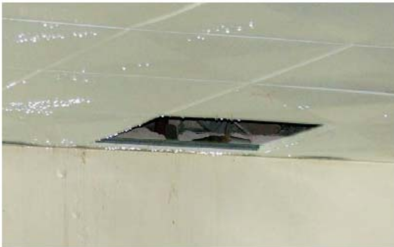
صورة الموقع رقم ١٨: المياه تتسرب من سقف ثكنة الطلاب العسكريين
