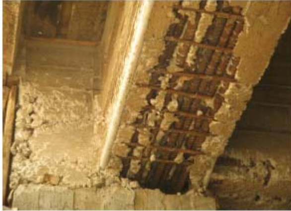
صورة الموقع ٢٥، دليل على التركيب غير الصحيح لعارضة تسليح مكشوفة، وماسورة بولي فينيل، وصداً
