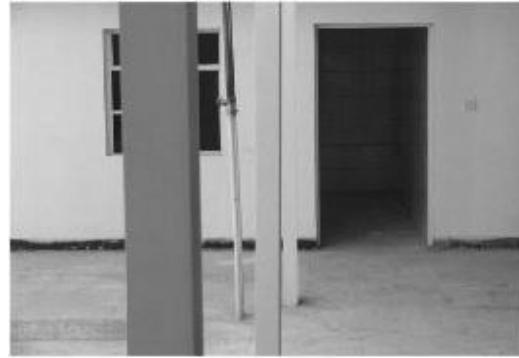
عارضات عمودية من الصلب مركبة خارج الترافف الصحيح (غير ملحمة) في حصن حدودي
