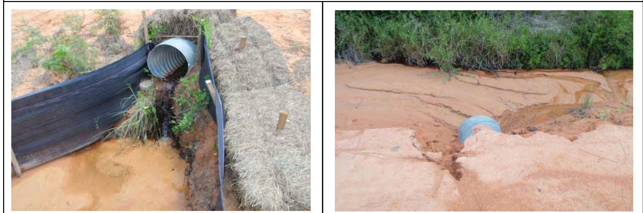
Crossing Structure: DS US
