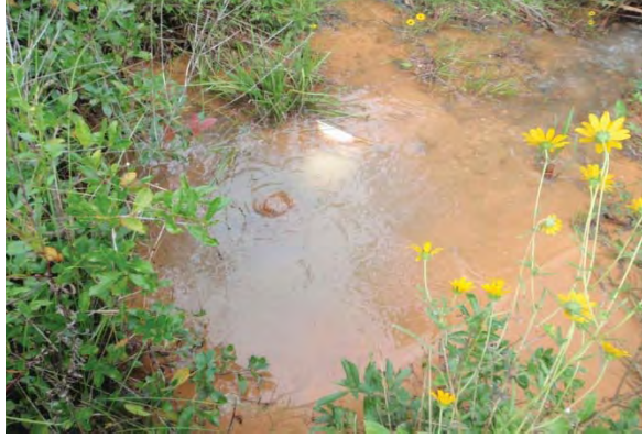
Crossing Structure: DS
