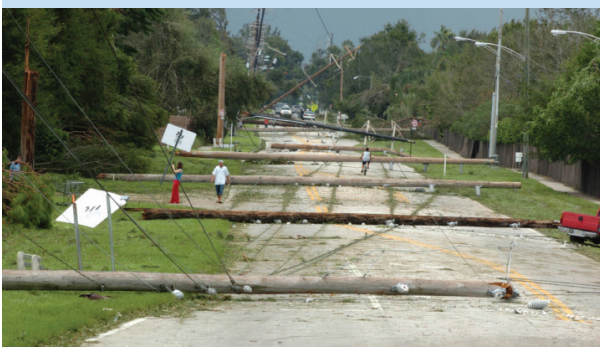
Daños por vientos del Huracán Charley, agosto de 2004, Orlando, FL/Orlando Sentinel, derechos de autor en 2004
