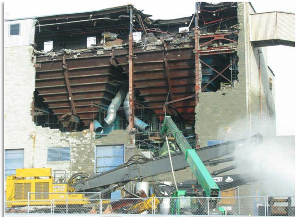
284E Powerhouse demolition
