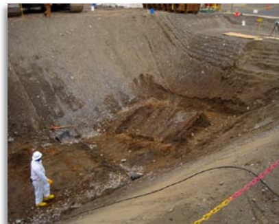
Empty 3A Trench 8
