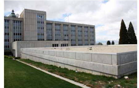
The Salt Lake Data Center
