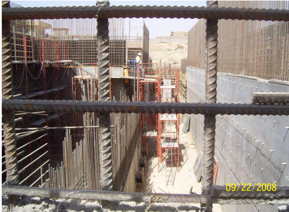
Site Photo 19. Pump Station F1 wall construction
