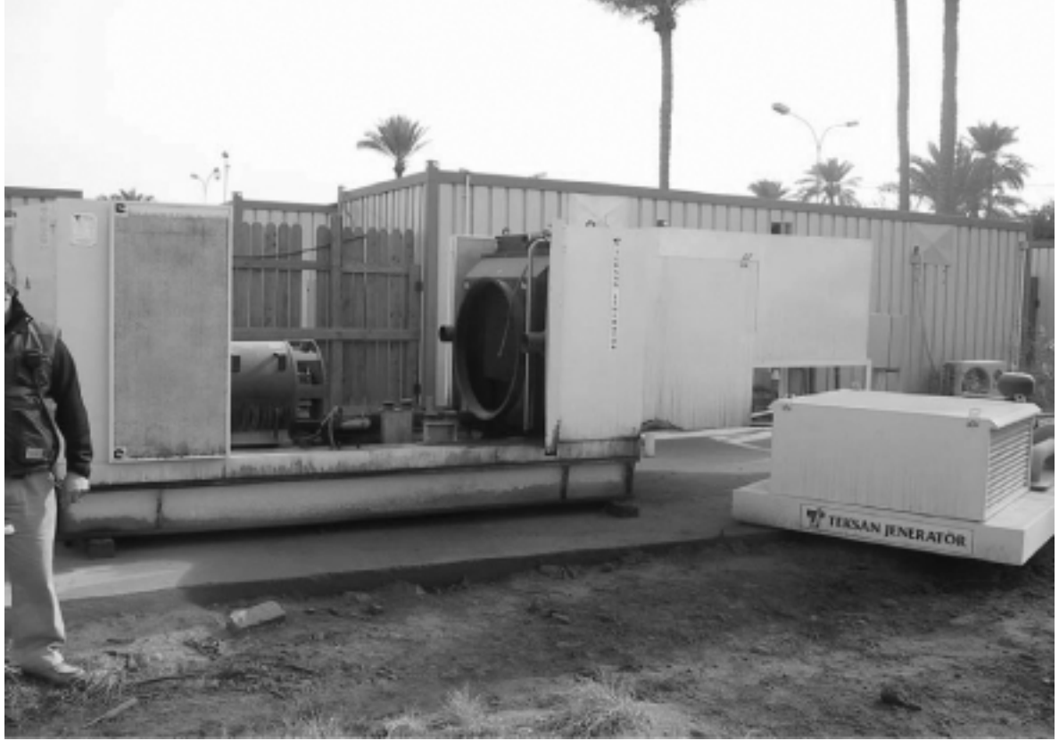
الصورة ١. هيكل المولد بقوة ٥٠٠ كيلواط قيد الإصلاح
