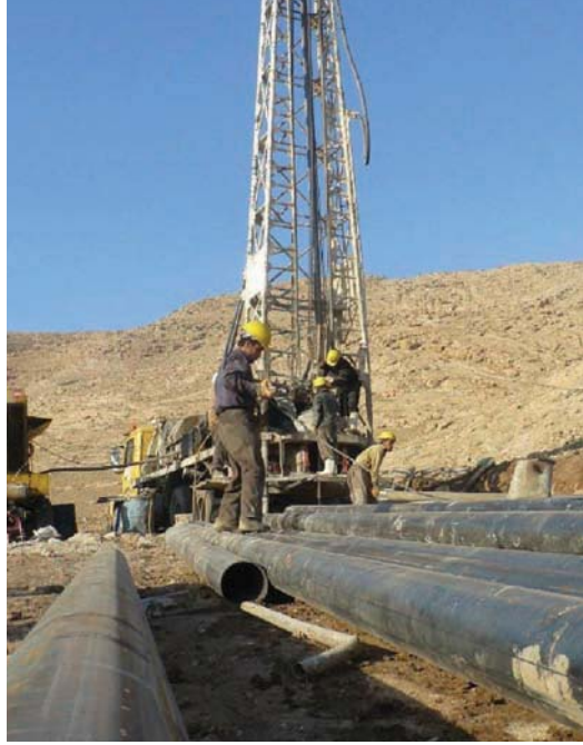
قيام العمال في العراق بحفر بئر لمياه الشرب. صورة الوكالة الأمريكية للتنمية الدولية
