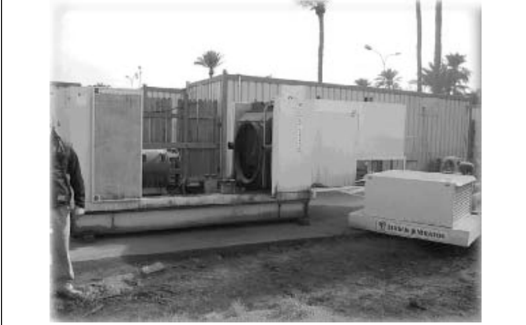
هيكل لمولد بقوة ٥٠٠ كيلواط الذي يخضع للتصليح في أكاديمية الشرطة ببابل
