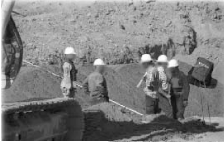
أنبوب مع تركيبات الاختبار للمياه عند المعبر النهري في شمال العراق
