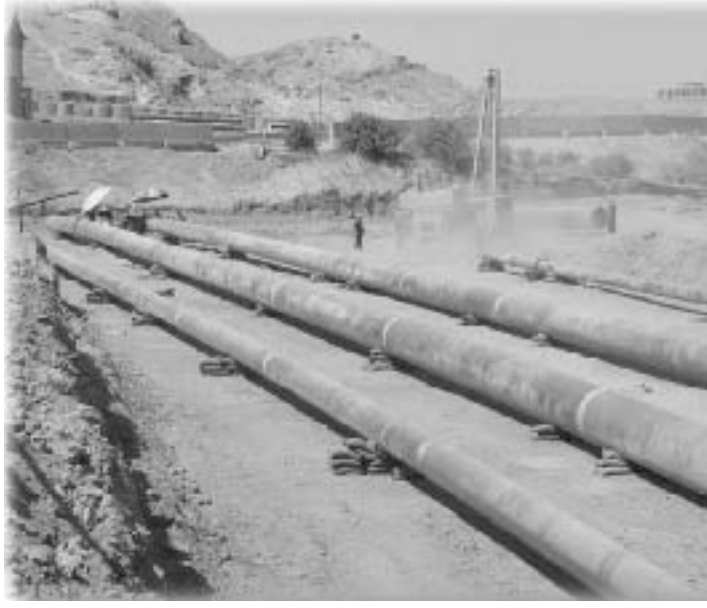
أشغال البناء في موقع وصلات ربط
