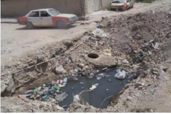
فتحة الصيانة الموجودة المنهارة قبل إكمال الإنشاء من جانب المقاول (الصورة مقدمة من سلاح الهندسة في الجيش الأميركي)
