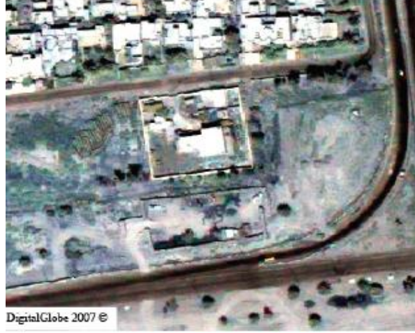
الصورة الجوية رقم 2- صورة التقطت في 19 أيلول/سبتمبر 2007 لمحطة المضخات في المنصور التي قيمها المفتش العام في التقرير رقم PA-07-111
