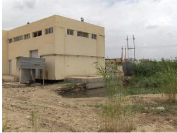
منظر خارجي لمحطة رفع مياه المجاري G-7 في الغزالية
