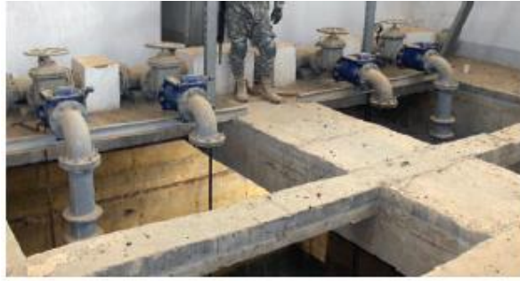
منظر داخلي لمبنى رفع مياه المجاري G-7 في الغزالية
