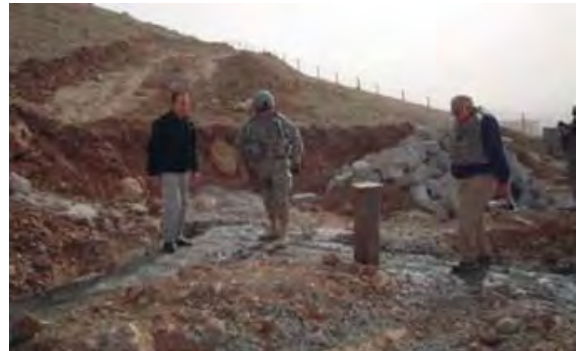
حفر آبار المياه الارتوازية
