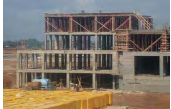
بناء مستشفى طوارئ في مدينة أربيل
