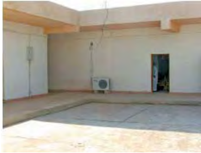
فناء مدرسة صغيرة ووحدة تكييف الهواء المجرأ
