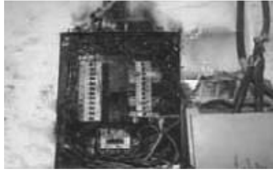
لوحة قواطع الدائرة الكهربائية مع علامة احتراق
