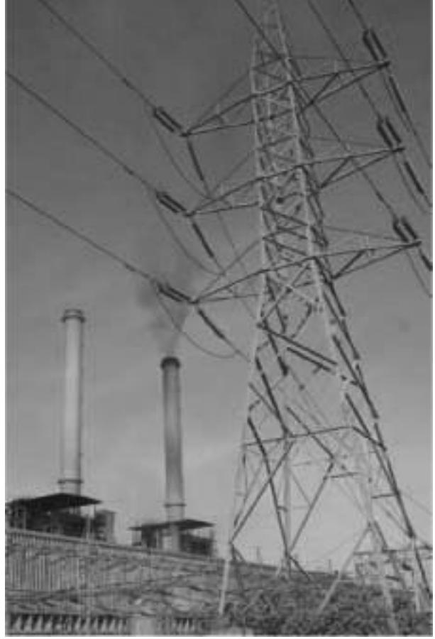
برج لنقل الكهرباء
