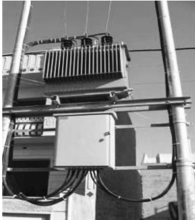
المحول ولوحة توزيع طاقة الفولتية المنخفضة
