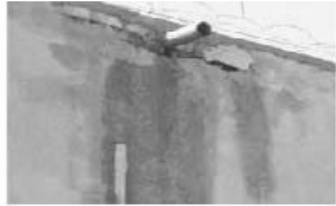
درينة تالفة حول مصرف مياه السقف الخارجي
