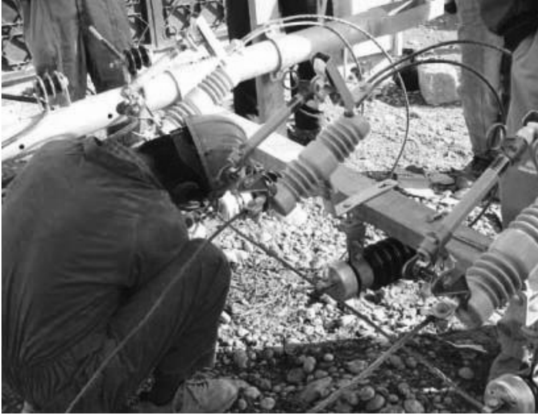
إعداد فتحات للمصاهر على محطة تحويل هوائية قبل التركيب
