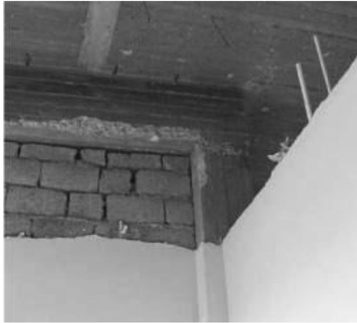
انفصال العتبة العلوية للسقف الحاملة للثقل المصنوعة من الخرسانة المسلحة
