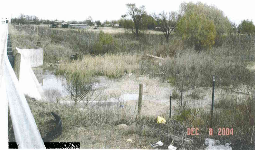
DS of WS Young Culvert
