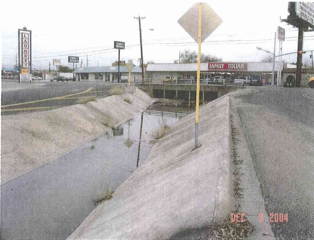
Rancier Ave culvert
