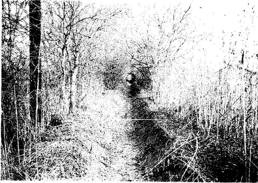
PHOTO 5 - TYPE E (Pull Ditch Near N. Calame Rd.)
