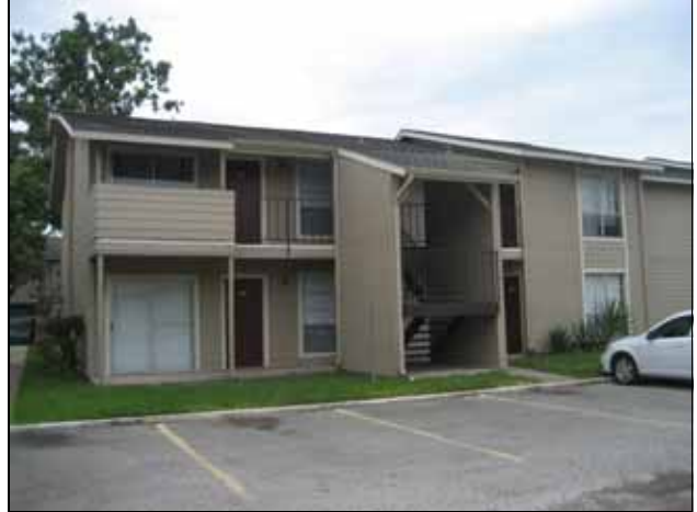
La Residencia Apartments
