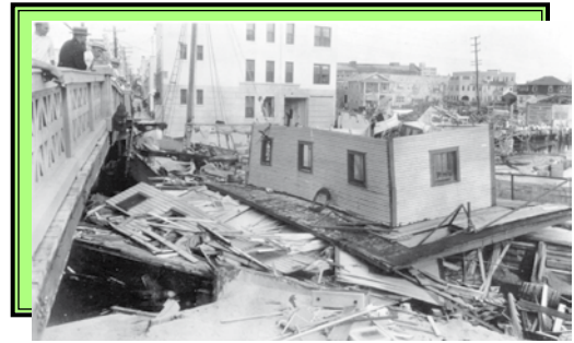
1926 - La burbuja especulativa de la construcción en Florida
