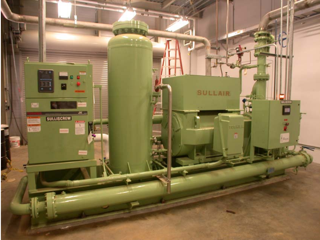
Fig. 5.2-40. Helium compressor.
