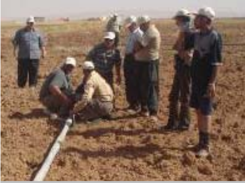
كادر من وزارة الزراعة يقومون بوضع الانابيب الجانبية اثناء جزء التدريب العملي من الفصل.
