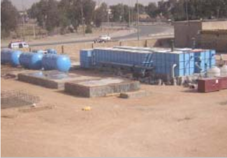
يستمر العمال في بناء حماية الاساسات لوحدات معالجة المياه المؤثة.
