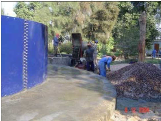
خزان تحلية المياه في احد مشاريع الطاقة الكهربائية.
