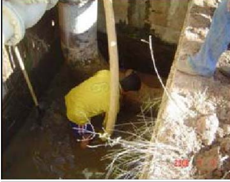
قام شركاء الوكالة الامريكية للتنمية الدولية باستبدال خط انابيب الاسبستوس القديمة والمتصدعة لتحسين نوعية وايصال المياه.
