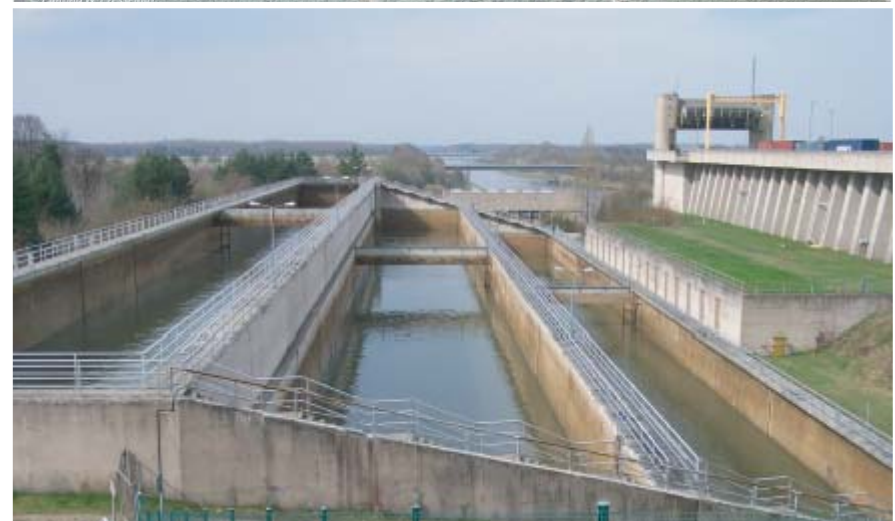
Tinas de reutilización de agua en la esclusa de Uelzen I en Alemania.
