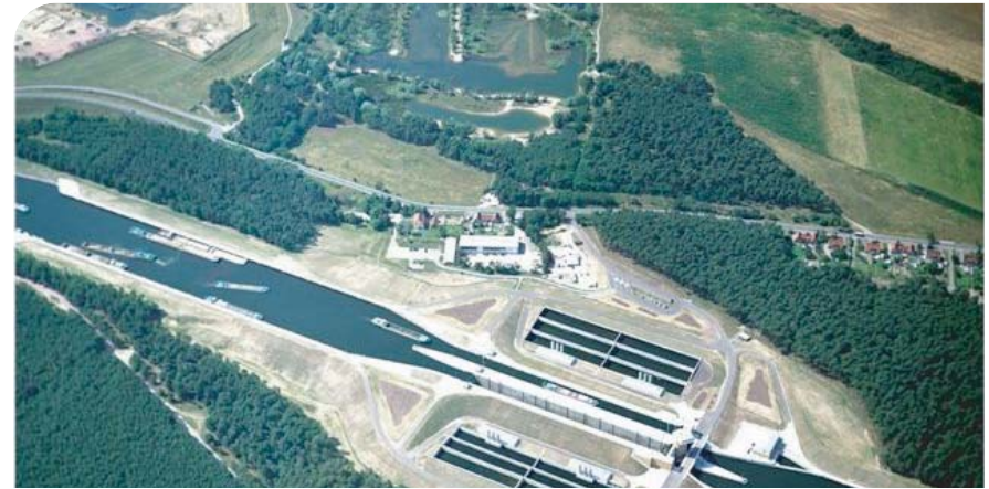
Esclusas de Hohenwarthe en Alemania, de dos vías con tres tinas paralelas de reutilización de agua por vía.
