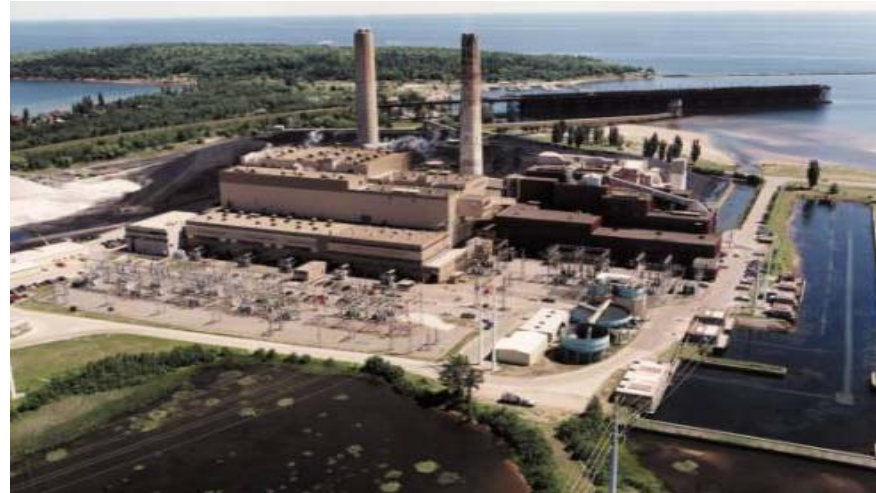
Presque Isle Power Plant, Marquette, MI
