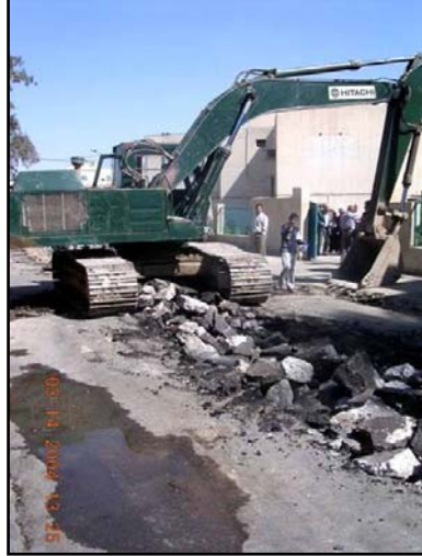
عملية اعادة تأهيل طريق في منطقة الكرادة.
