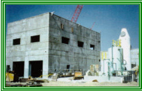
Planta Internacional de Tratamiento de Aguas Residuales de South Bay, San Diego, California, EE.UU. La construcción del edificio de obras de cabecera y equipos de control de olores.
