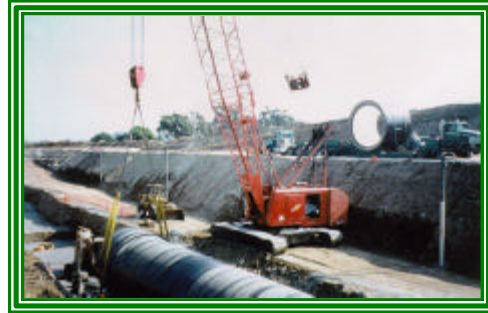
Instalación de un tubo de efluentes de 12' de diámetro para la Planta Internacional de Tratamiento de Aguas Residuales de South Bay en San Diego, California, EE.UU.
