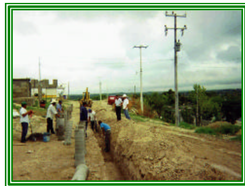
Instalación de alcantarilla en Ciudad Acuña, CO, México.
