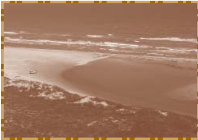
Por primera vez en la historia reciente, la desembocadura del Río Bravo quedó bloqueada con sedimentos durante el mes de febrero del 2001. Cinco meses después, la CILA dragó un canal de 20 pies de ancho a través de la barrera de arena de 440 pies de longitud. Crédito fotográfico: Randy Blankinship, Texas Parks and Wildlife Department.
