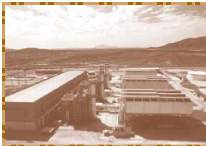
Esta termoeléctrica de ciclo combinado de Samalayuca, está ubicada cerca de Ciudad Juárez, Chihuahua, y El Paso, Texas, y utiliza condensadores enfriados con aire. Crédito Fotográfico: GEA Power Cooling Systems.
