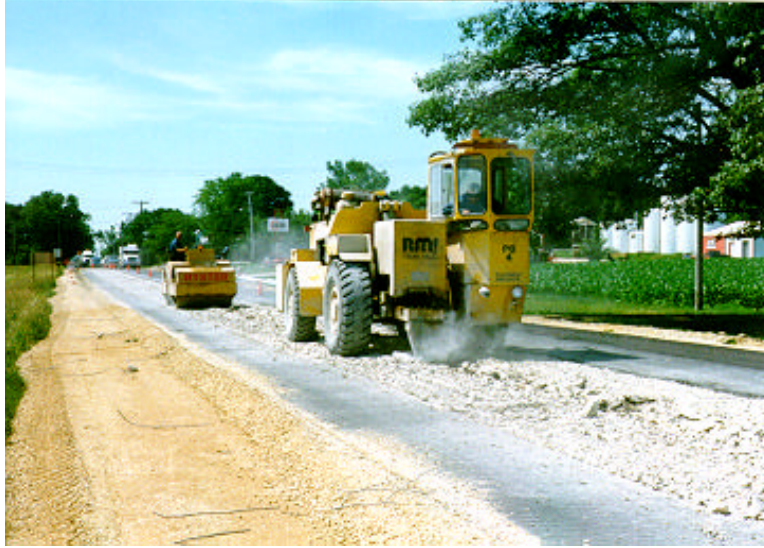
Figure 10. Rubblizing Process (IL 38 1994).
