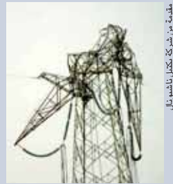
برج معطل لاسلاك الطاقة الكهربائية (أعلى)، واحد من مئات الأبراج التي سرقتها اللصوص لبيع الاسلاك النحاسية.
