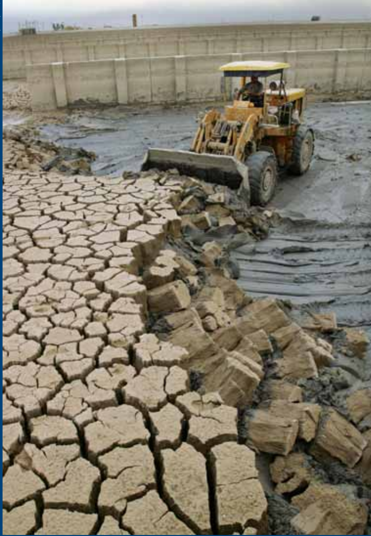
إزالة الطمي الجاف من خزانات قناة المياه العذبة. يوفر نظام القناة المياه لـ ١٧٥ مليون شخص في محافظة البصرة.
