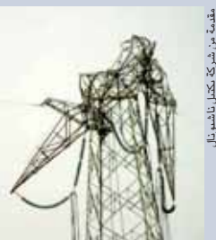
برج معطل لاسلاك الطاقة الكهربائية (أعلى)، واحد من مئات الأبراج التي سرقتها اللصوص لبيع الاسلاك النحاسية.
