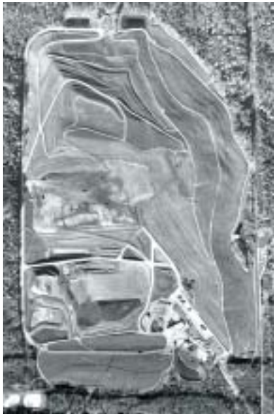
Cedar Hills Regional Landfill
