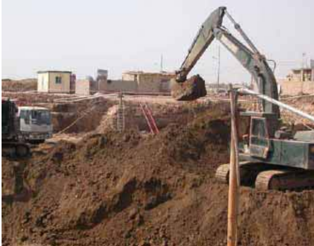
اعمال الحفريات والتنقيب التي تسبق اعمار محطة الضخ كجزء من احد البرامج لاعادة نظام المجاري في احد مناطق بغداد.
