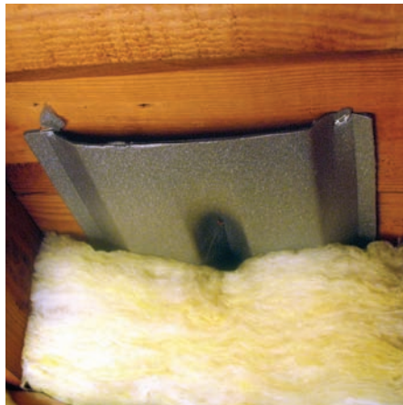
Agregue aislamiento alrededor de la lámina de ventilación hasta el suelo del ático. Foto cortesía de Doug Anderson
