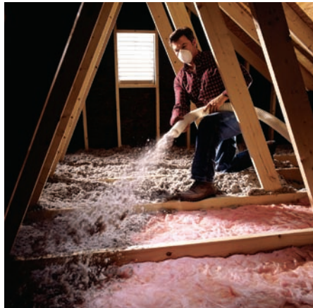
Use una máquina sopladora para absorber el aislamiento esparcido.
