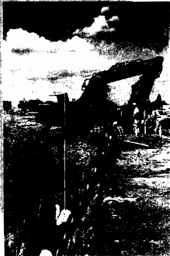
Saneamiento de Mexicali
