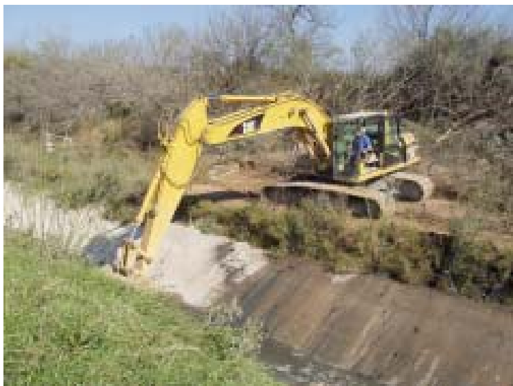
Mantenimiento del Dren El Morillo
