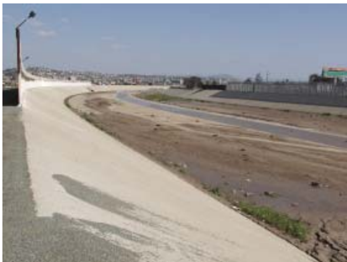
Proyecto de Control de Avenidas del Río Tijuana
