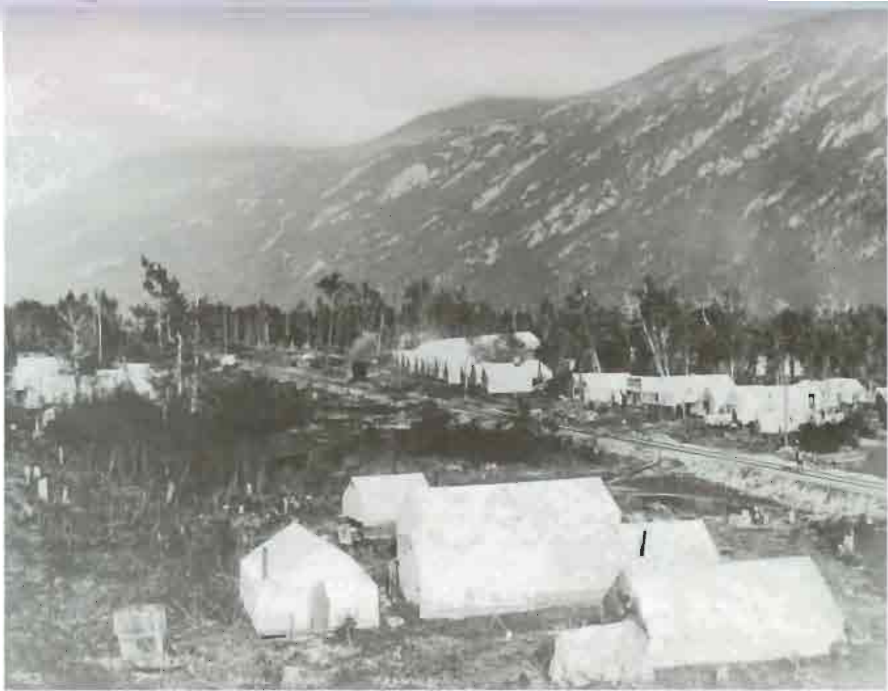
Tiekel construction camp
