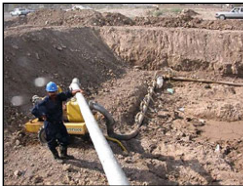
عملية تصريف المياه لاعادة تأهيل نظام مجاري بغداد .
