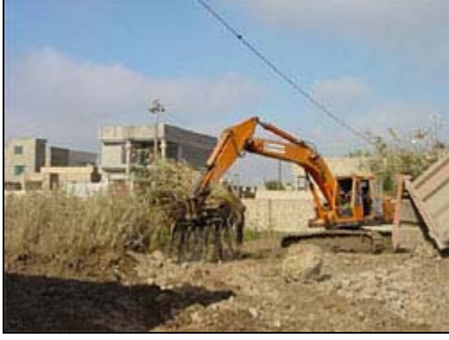
جرافة تقوم بأزالة الشجيرات والزوائد النباتية وتنظيف المستنقع في ثانوية ابن سينا في الحلة. الصورة: USAID
