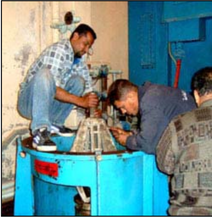
يقومون بأصلاح محطة الرصافة لضخ المياه في شمال بغداد.
