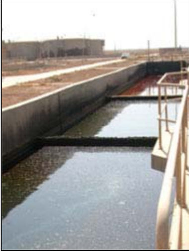
المياه الثقيلة في مشروع الكرخ لمعالجة المجاري.
