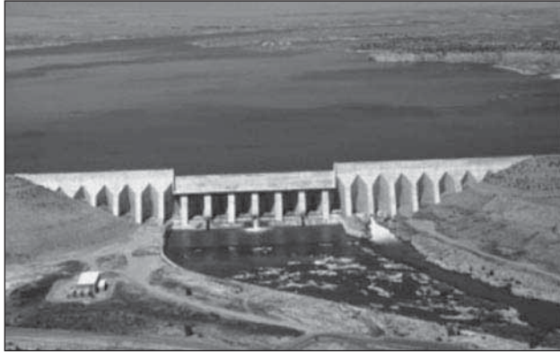
1.49. Pueblo Dam, Colorado.
