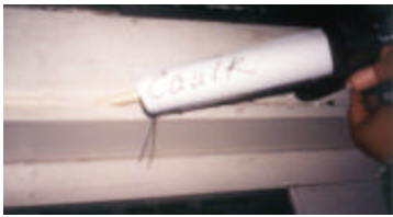
Selle las grietas y las rajaduras
