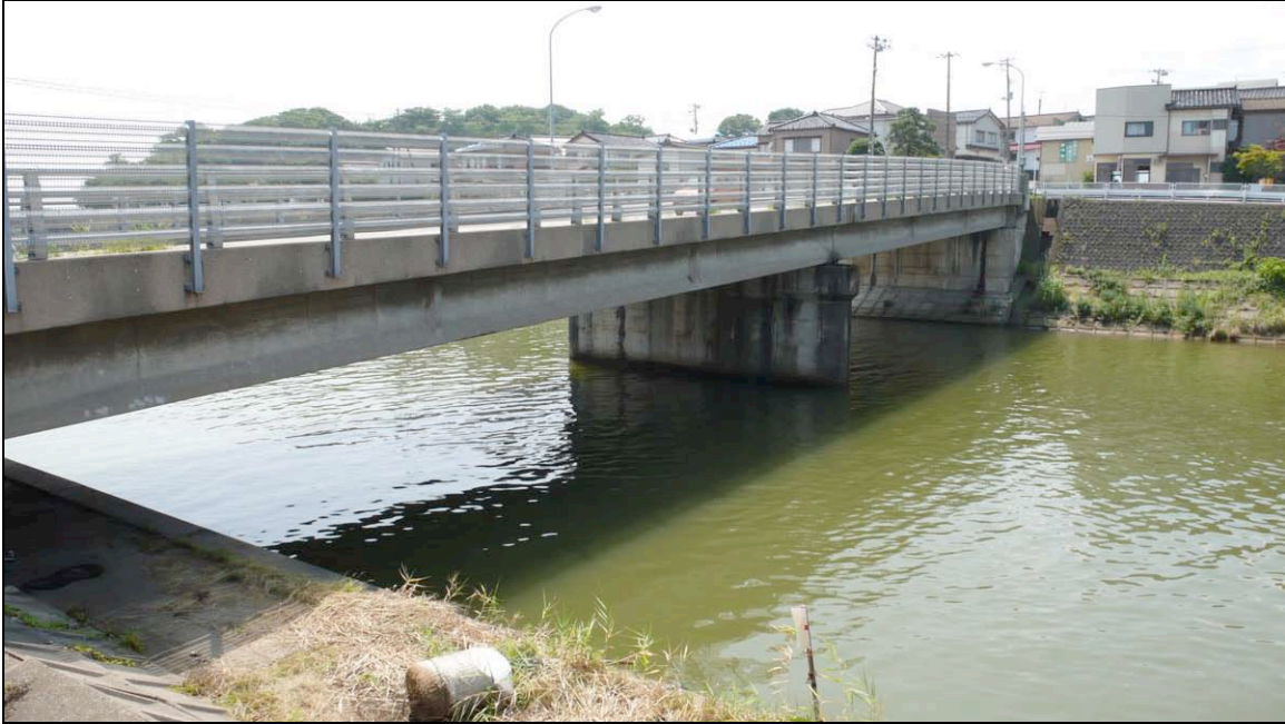
Fig. 6.57. The Ukawa Bridge.
