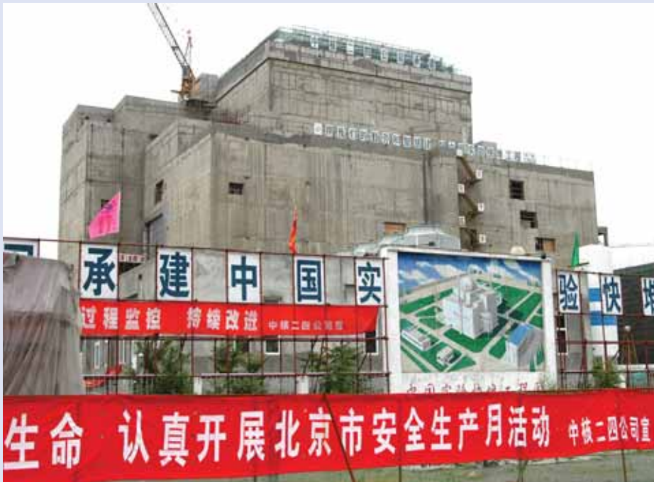
全速前进：中国第一个试验性快堆核反应站正在 Tuoli 加紧建设中
