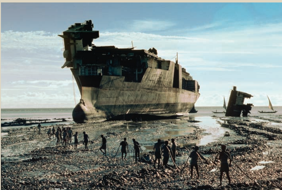
艰巨的任务：拆船工人和吉大港附近的工人一样，常常缺少最基本的个人防护设施，从而可能面临诸如石棉、有毒气体和爆炸的风险。
