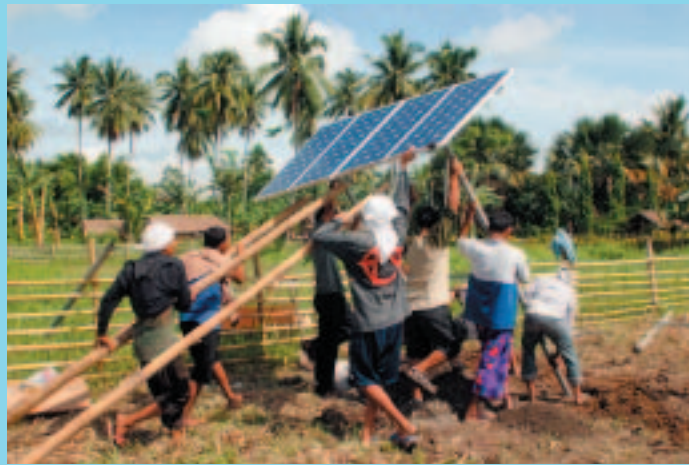
Aldeanos colocan un panel fotovoltaico solar en Mindanano, Filipinas.
