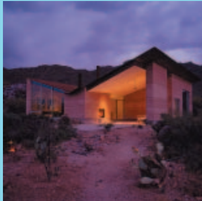
La Tucson Mountain House, con paredes de tierra apisonada, diseñada por Rick Joy
