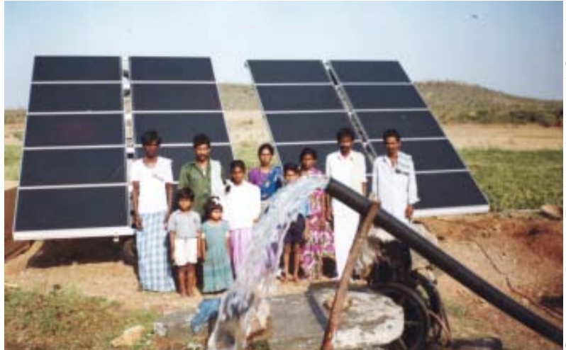
Bomba alimentada por energía solar en India, parte de un proyecto del Oficina de Desarrollo de Energía Renovable.
