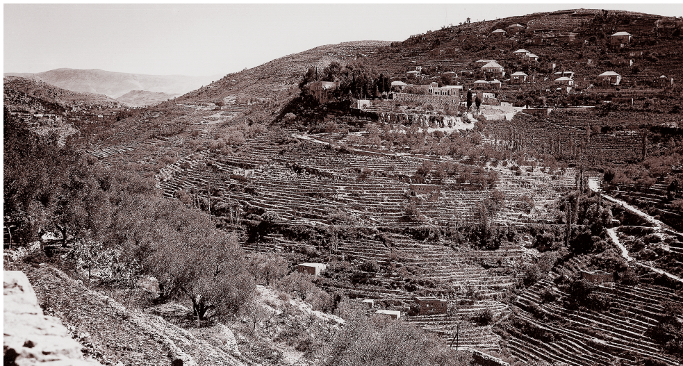
Figura 5. Terrazas con bancos basándose en paredes de piedra que han estado en uso por miles de años, en el Líbano. La construcción de terrazas de este tipo costaría entre $2,000 y $5,000 por acre si el salario fuera de 40 centavos por hora. Tales métodos tan costosos de protección de la tierra son prácticos solamente donde la gente no tiene otro territorio para cultivar sus alimentos.
