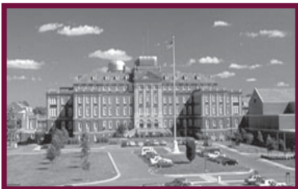
Tuscaloosa VA Medical Center Tuscaloosa, AL
